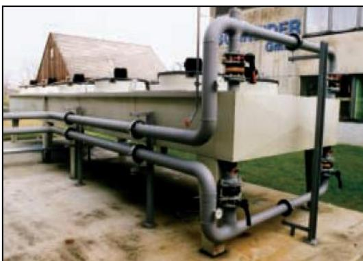
**Şekil 10.** Sistemde kurulu kuru soğutucu [16]
